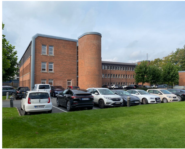
Figur 3: Lokalplanområdet anvendes primært som parkeringsplads i dag. På fotoet ses Boulevarden 19A og 19B.
