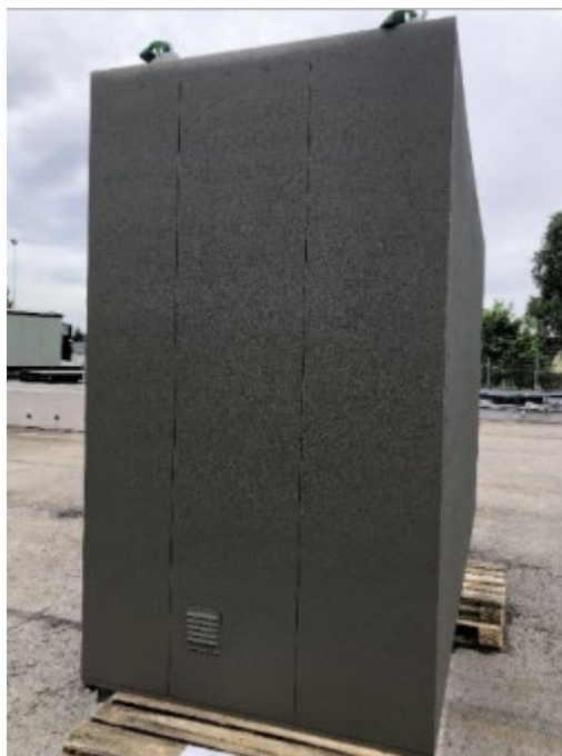
Figur 3-9 Eksempel på sekundær koblingsstation.
