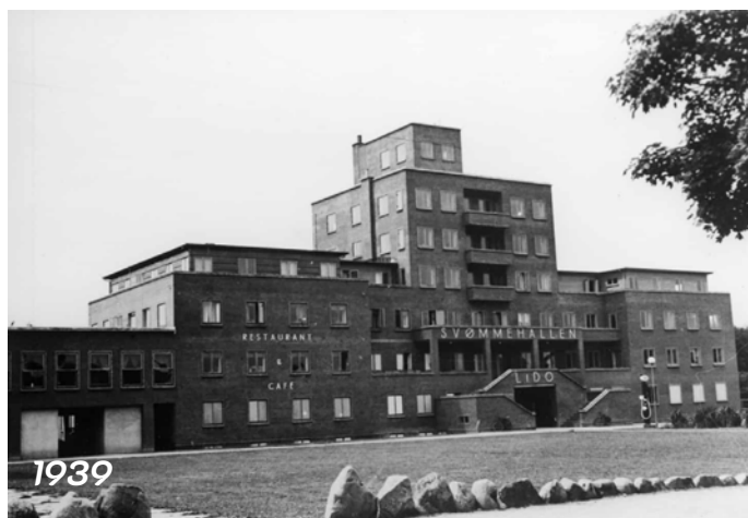
1939 Foto fra Arkiv.dk. Facader mod Fredericiavej, da hovedbygningen er fuldt udbygget.
