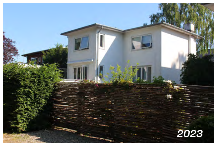
Betel Nielsens Vej 5 - facade mod Bertel Nielsens Vej.
