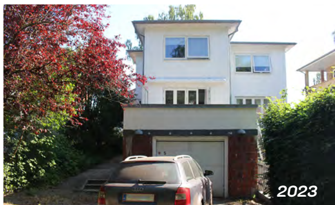
Betel Nielsens Vej 5 - facade mod Bertel Nielsens Vej.
