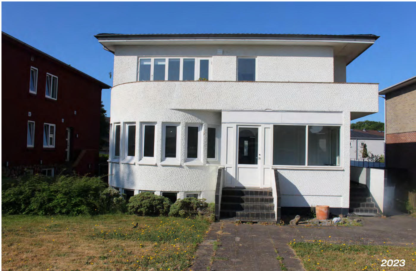
Facade mod Fredericiavej. Fredericiavej 100 har fået et tag med blanke tagsten. Hvis taget udskiftes, skal det føres tilbage til tagpap.
