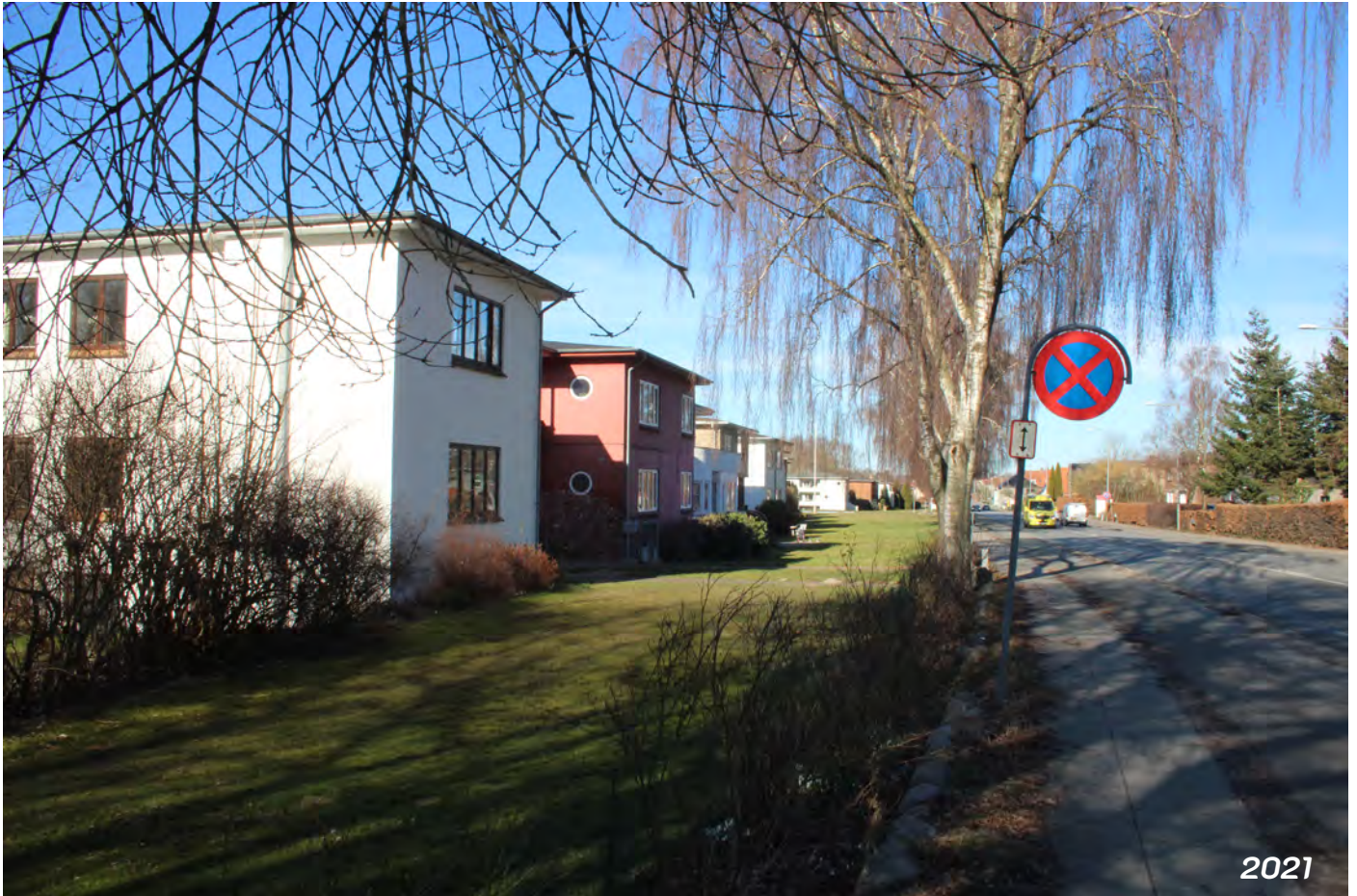
Facade set fra sydøst og Fredericiavej.
