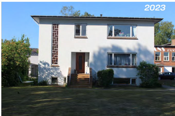
Facade mod Fredericiavej.
