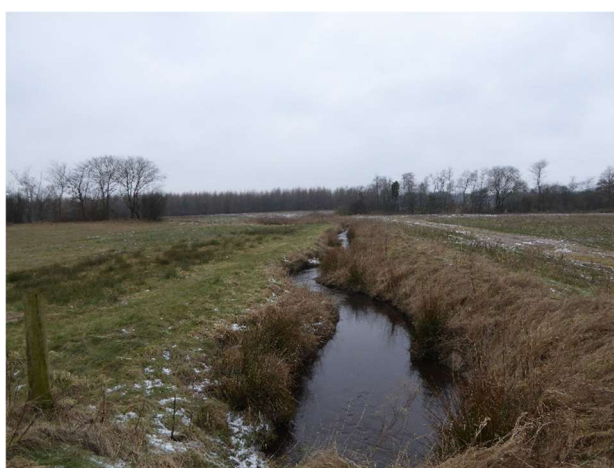
St.5285. Mørupvej, set nedstrøms. Kanaliseret.
