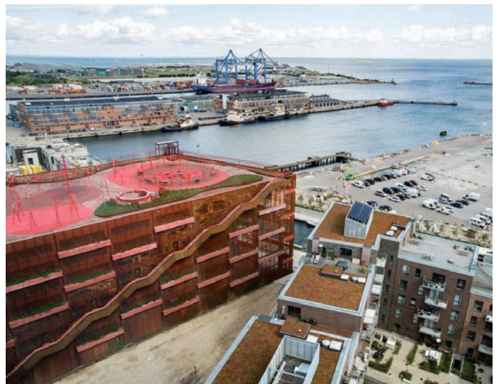
Nordhavnen - nye bygninger og byrum 2016
