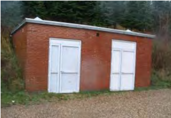
Nr. Vilstrup Vandværk
