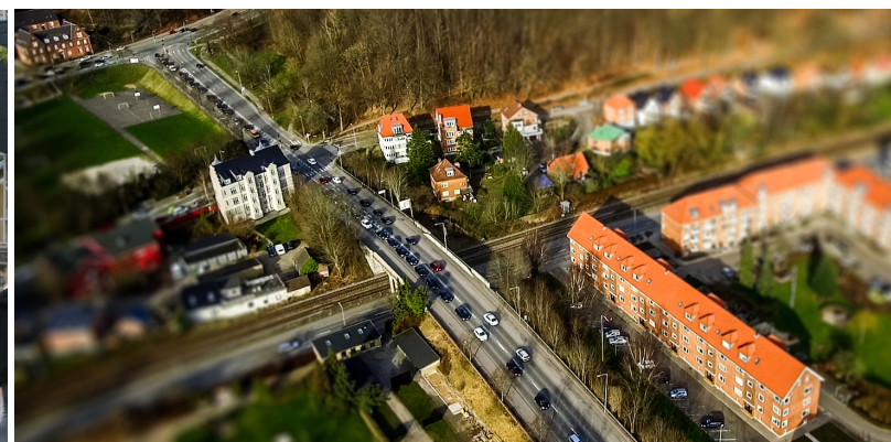
Der er trængsel på Havneruten, der derfor skal udbygges fra to til fire spor.
